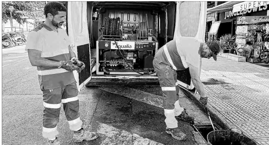
Operarios de Aqualia limpiando los imbornales de la ciudad de Ibiza. Foto: AYUNTAMIENTO DE EIVISSA
