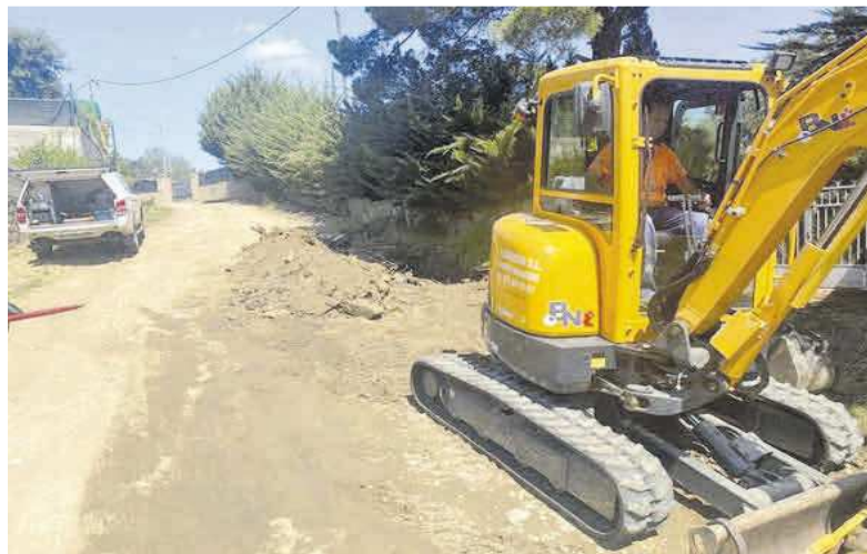
Una màquina treballant en la reparació de les canonades de Selva Brava.
